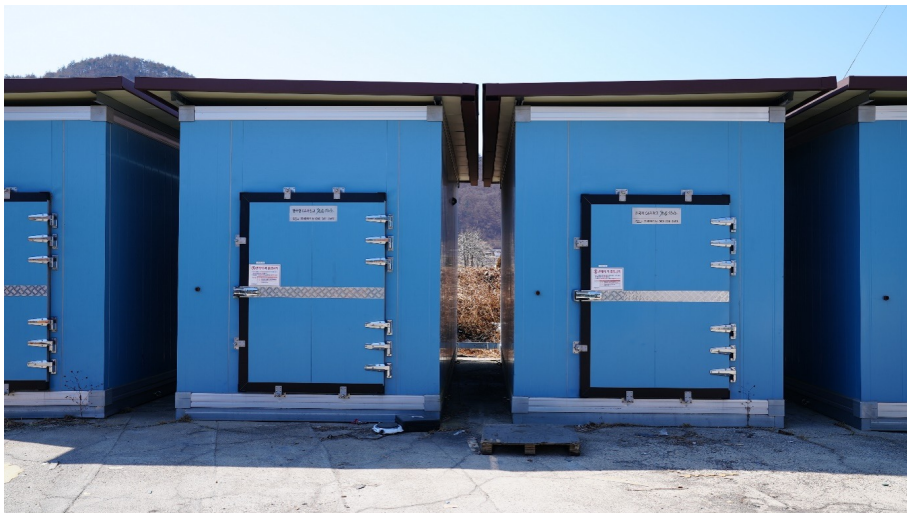
한우리 영농조합이 설치한 고성능 CA 저장고
