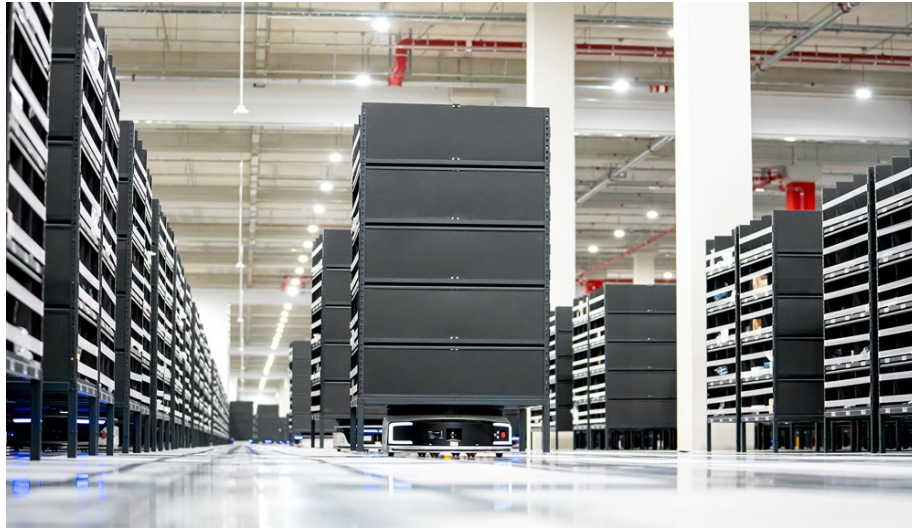
쿠팡 대구 풀필먼트 센터, 상품이 진열된 선반이 근무자에게 이동해 상품의 진열과 집품 작업을 자동화한 'AGV 로봇'
