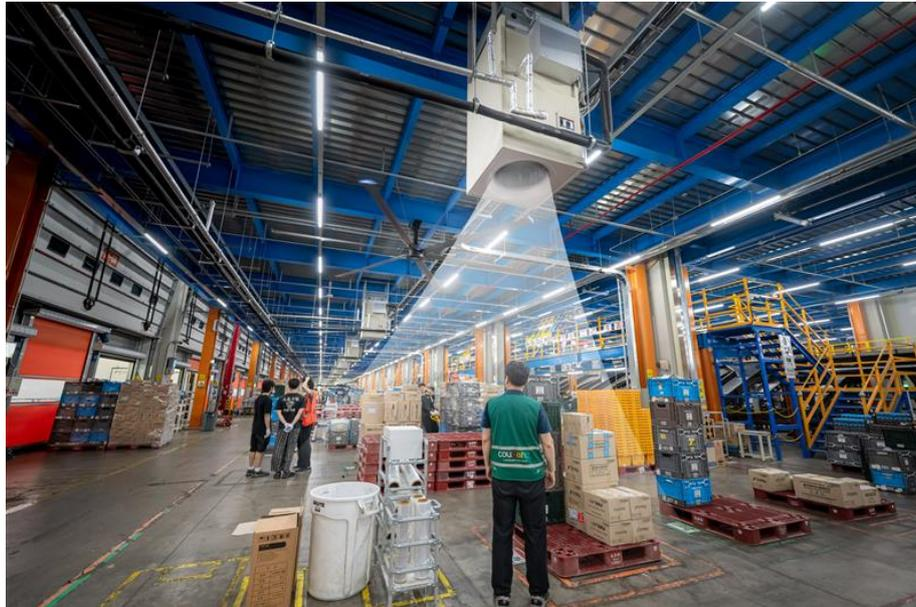
이천2센터 허브 공정에 설치된 대공간 냉방기기(Unit Cooler)와 대형 실링팬(HVLS). 대형 실링팬이 찬 공기를 순환시켜 냉방 효과를 높인다.
