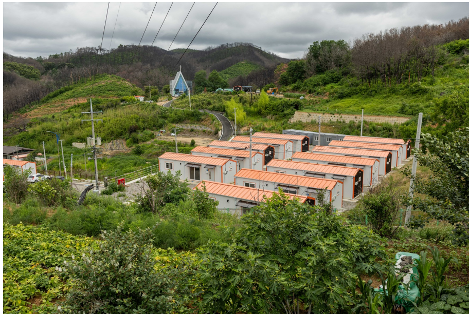
경북 산불로 집을 잃은 주민들이 현재 거주 중인 임시 조립주택 전경
