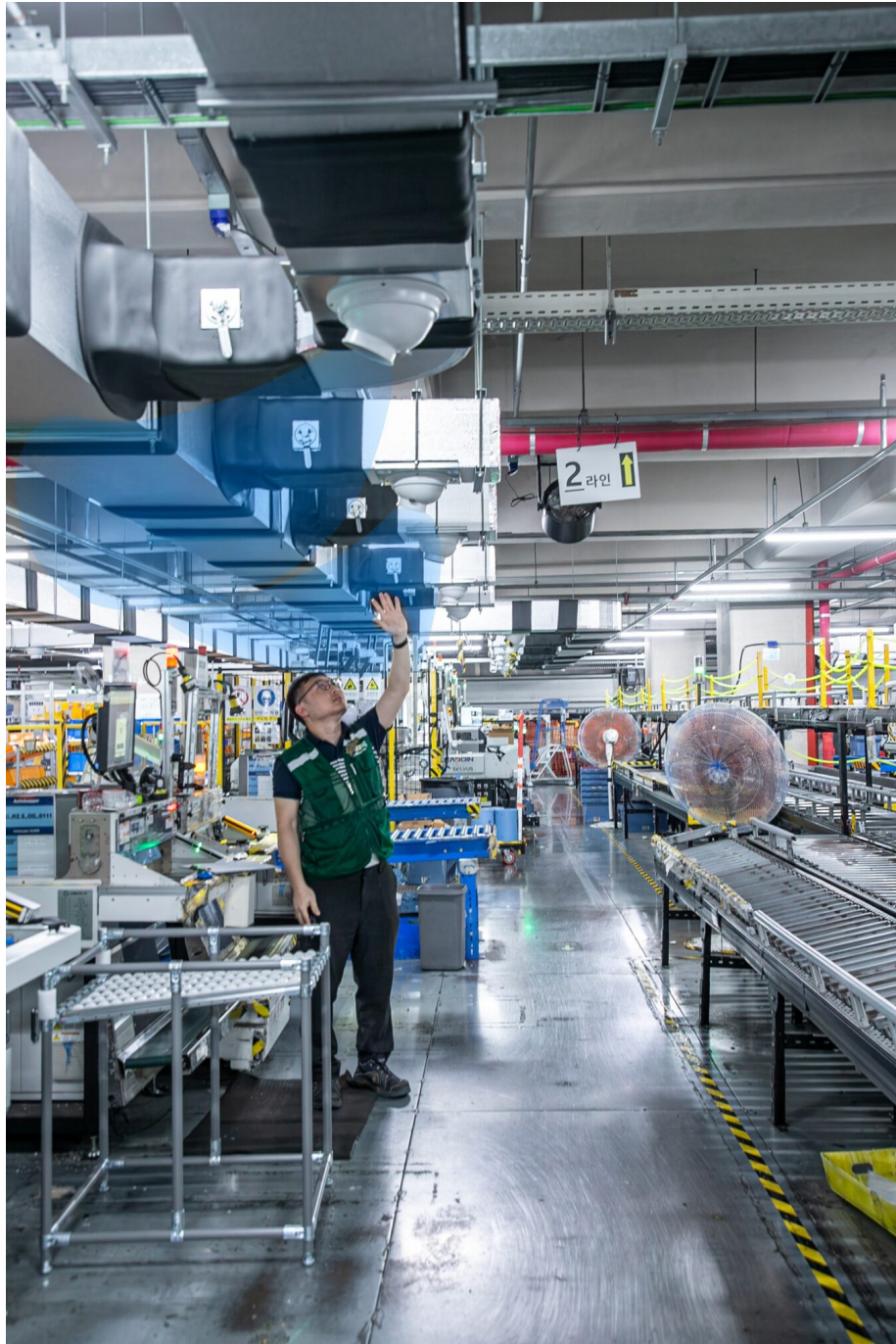
양산센터 집중근무구역에 설치된 천장형 시스템에어컨. CFS는 근로자들이 편리하게 휴식을 취할 수 있도록 공정 내에 냉방시설이 완비된 쿨존(Cool Zone)을 확대하는 등 혹서기에 철저히 대비하고 있다.
